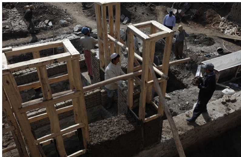
عکس از باز سازی تهداب ها و دیوار ها
