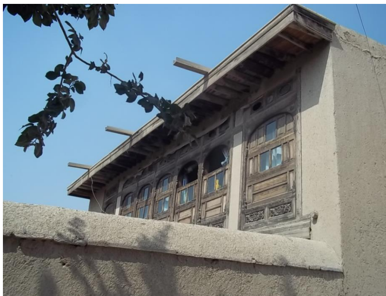
عکس یکی از خانه های قدیمی ( خانه طاوس )
