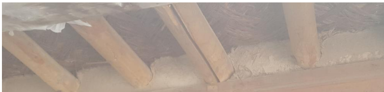
عکس از سقف پیک اتاق بدون مسطح
