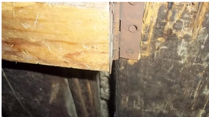
عکس از محکم کردن تمبه دروازه ادخال یکی از حویلی ها
