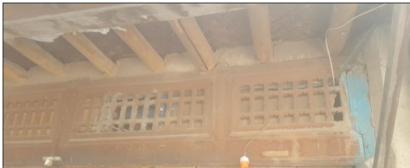
عکس از سقف پیک اتاق بدون مسطح
