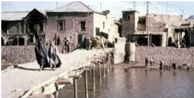
عکس قدیمی از پل یک پیسه گی بالای دریای کابل
