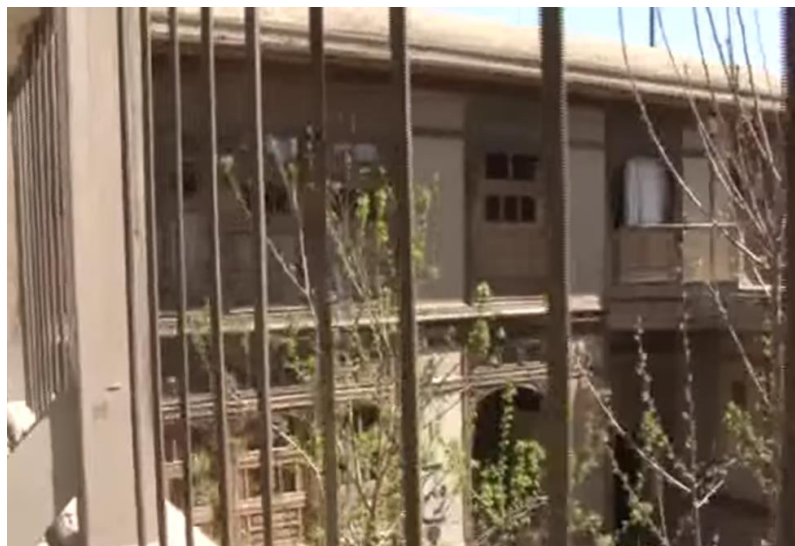
عکس یکی از خانه ها بعد از باز سازی
