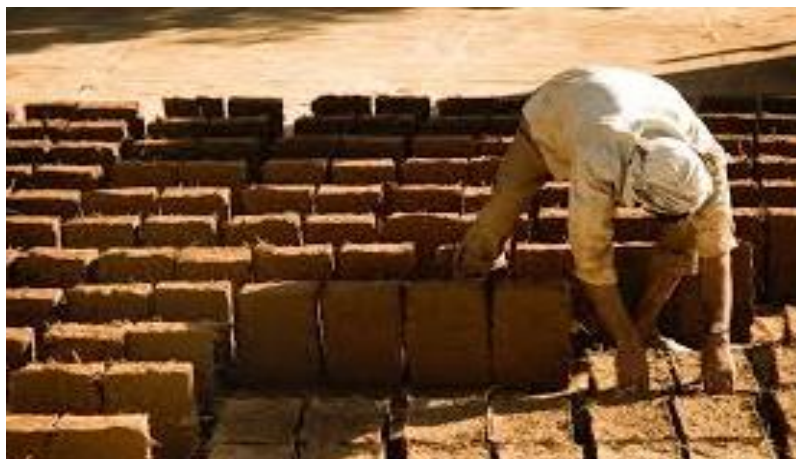
عکس از خشت ریزی برای ساختمان ها
