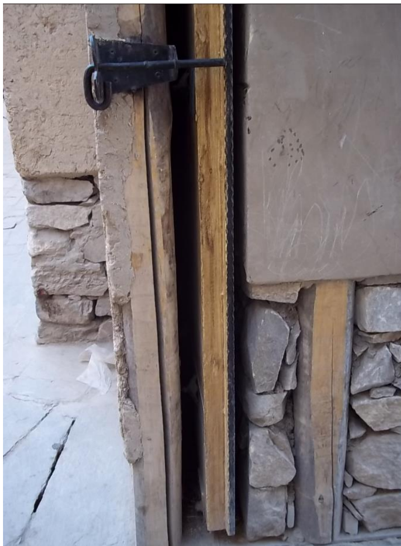
میداني د کوڅي دروازه چې د ښویدو (سلايدنگ) په توگه تړل کېږي
