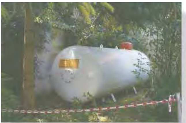
د فشار سلنډری ذخیروی جوړښت لکه پورته د ګازو ټانک ، دواړو خواوو ته د هموار په ځای، نیم کروی سرونه لری تر څو چې په ټانک کې فشار لږ شی.
