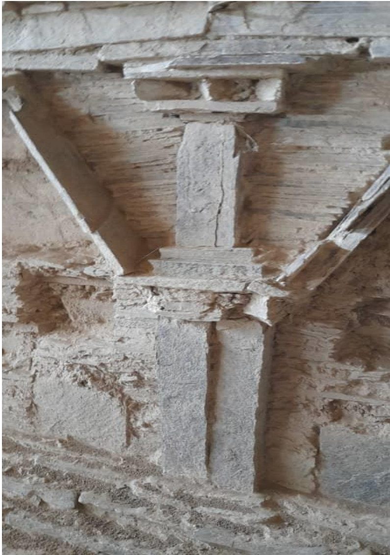
تصویر بخشی از استوای منطقه مس عینک
