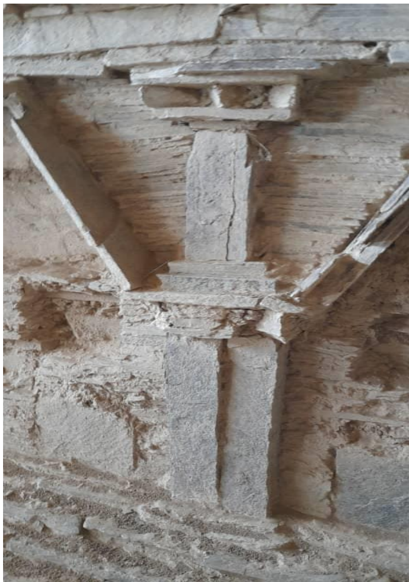
تصویر بخشی از استوای منطقه مس عینک
