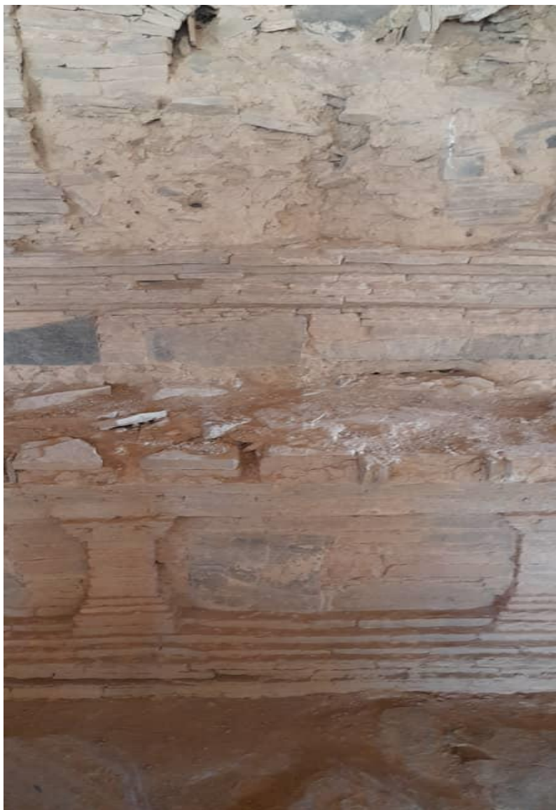
تصویر بخشی از استوای منطقه مس عینک
