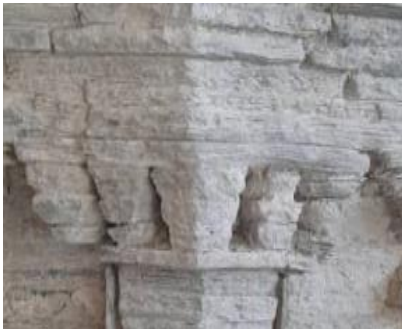
تصویر بخشی از استوپای منطقه مس عینک
