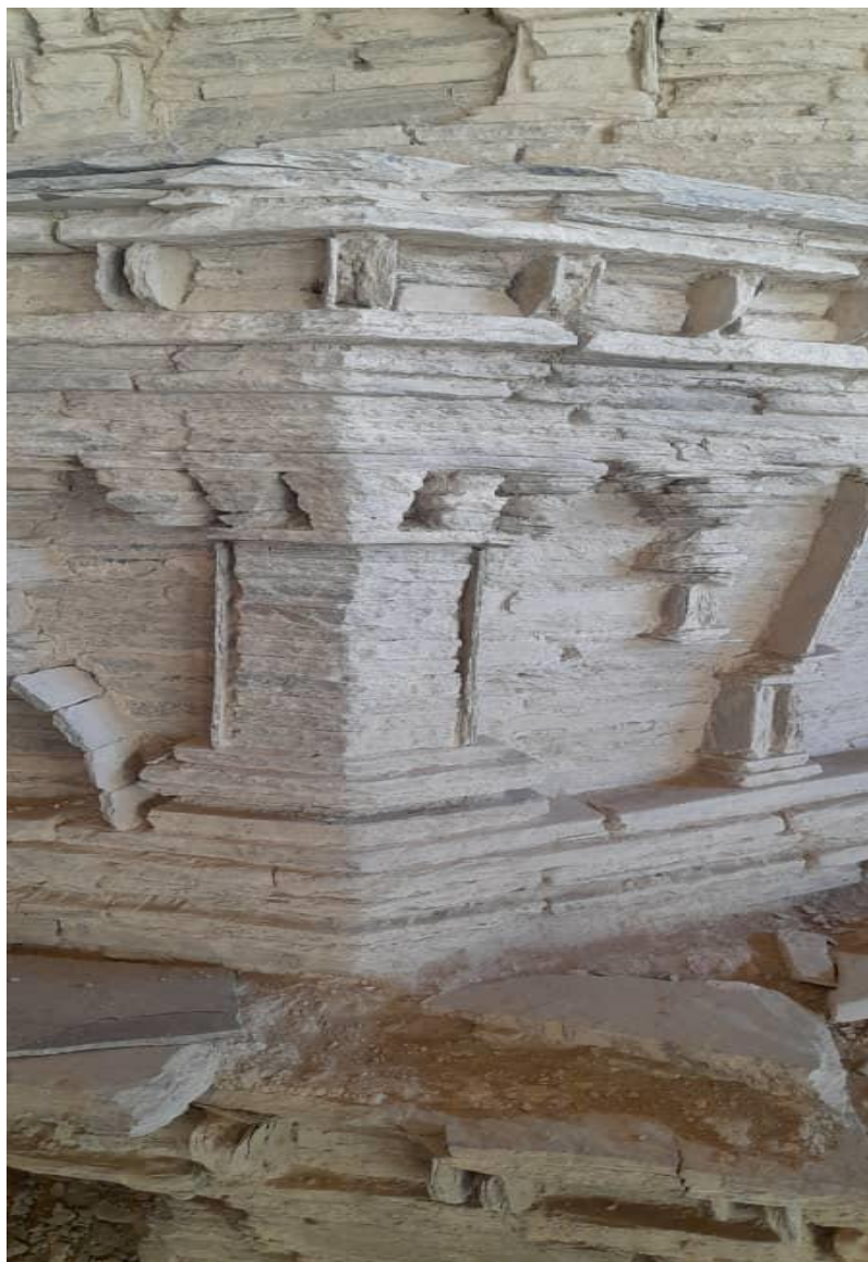
تصویر بخشی از استوای منطقه مس عینک
