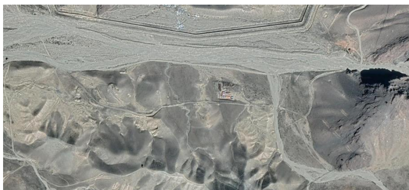
تصویر فضایی (هوایی) ساحه شهر مس عینک
