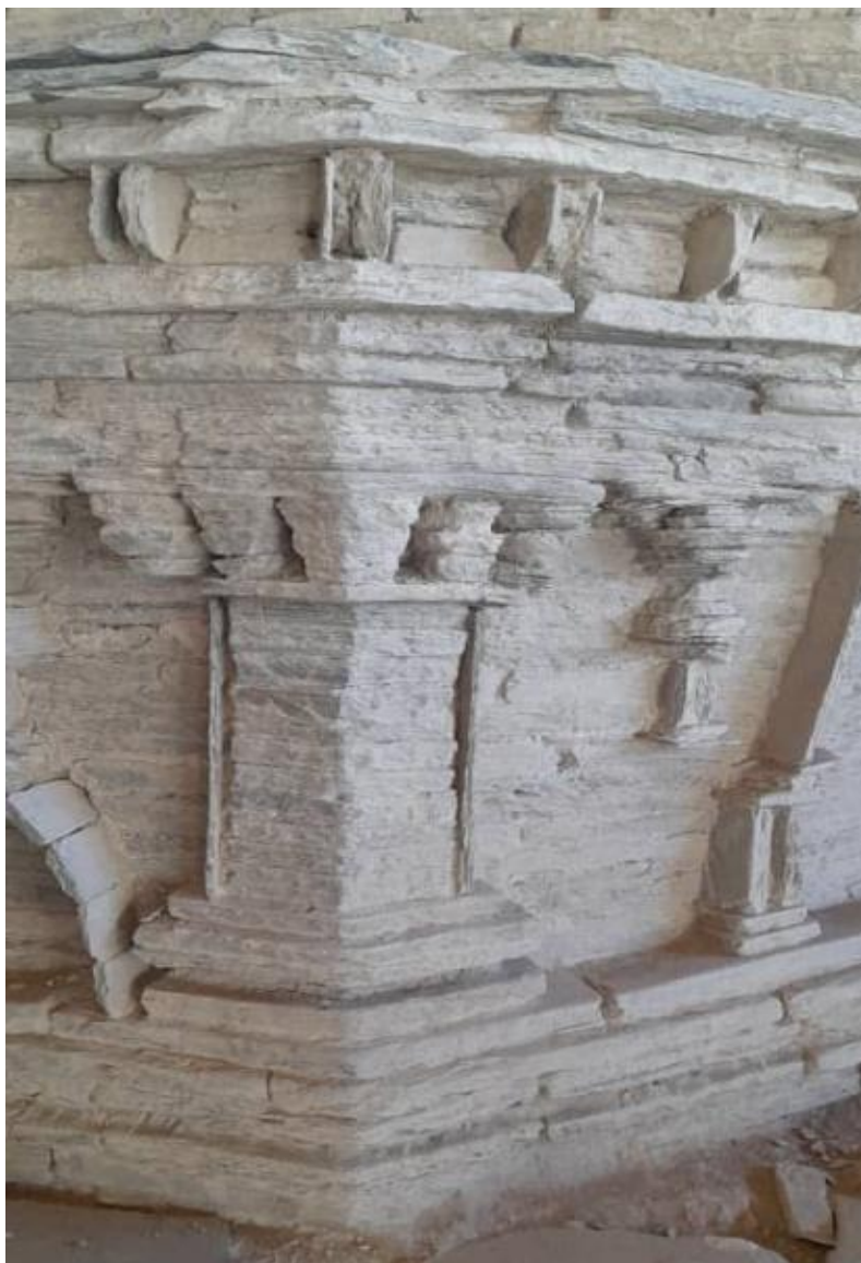
تصویر بخشی از استوای منطقه مس عینک
