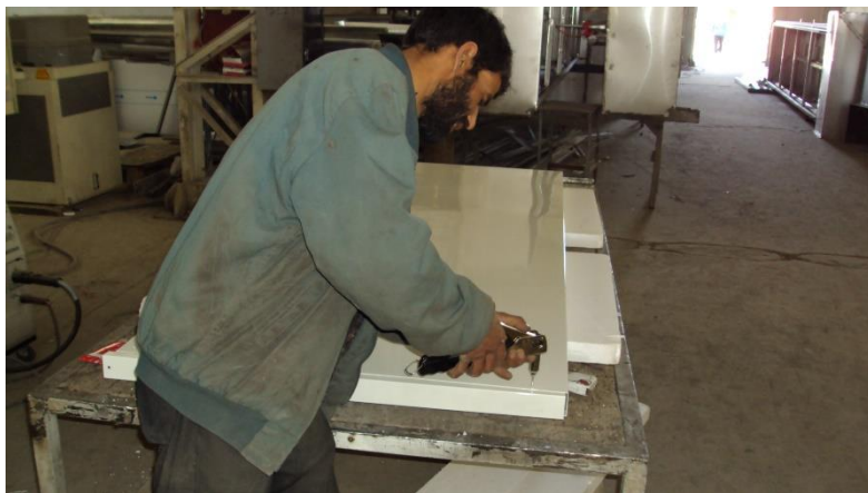
تصویر ریوت کاری بعد از عایق کاری پله های رنگ شده دروازه کانتینر تی آی ام
