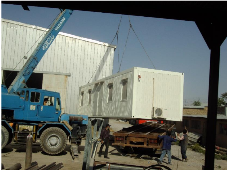
د تی آی ام د کانکس پورته کولو او بارگیری انخوړ
