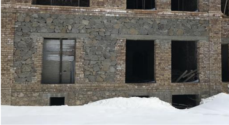
تصویری از قصر حرمسرا در جریان ساختمان
