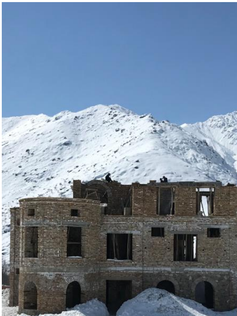
تصویری از قصر حرمسرا در جریان ساختمان
