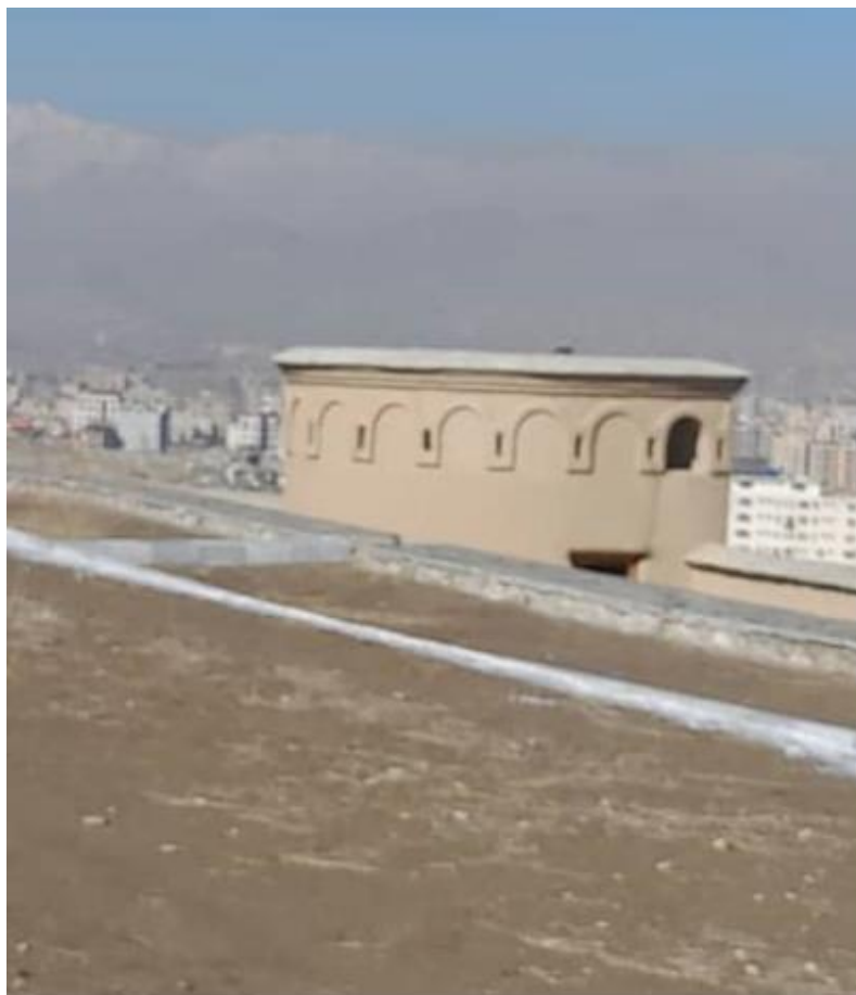
تصویری از قسمت بیرونی برج داخلی قلعه
