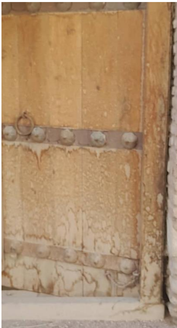
تصویر قسمتی دروازه ادخال یکی از تونل‌ها (بونکرها)
