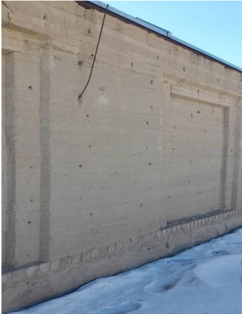
تصویری از دیوار احاطه قسمت سمت جنوب
