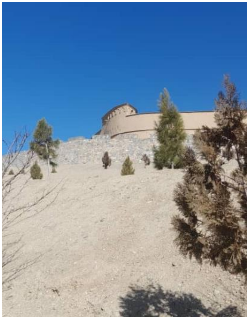
تصویری از قسمت بیرونی برج داخلی قلعه
