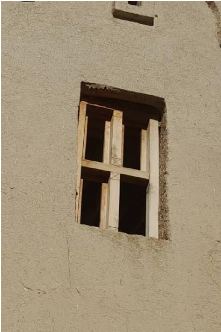
تصویری از قسمت برج های داخلی قلعه
