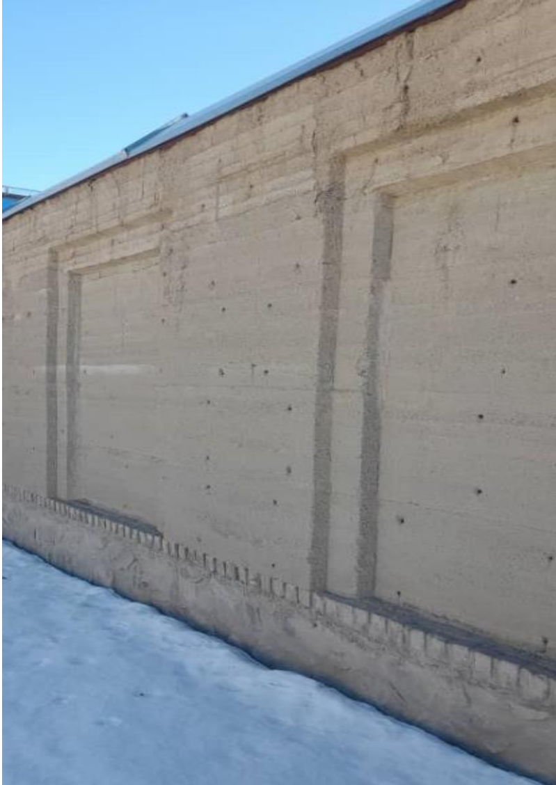
تصویری از دیوار احاطه قسمت سمت جنوب
