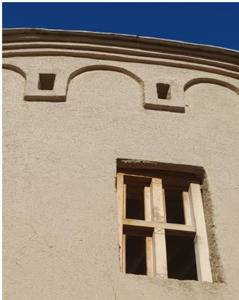
تصویری از قسمت برج های داخلی قلعه
