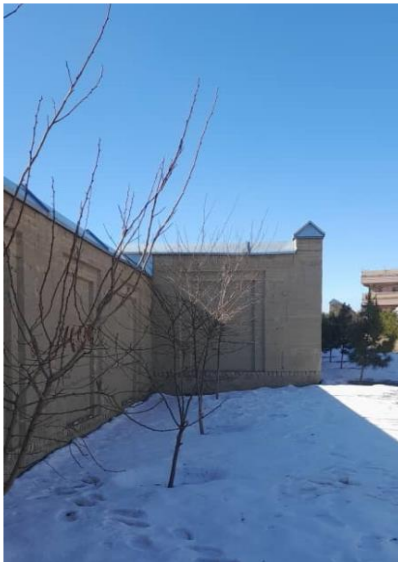
تصویری از دیوار احاطه قسمت سمت جنوب
