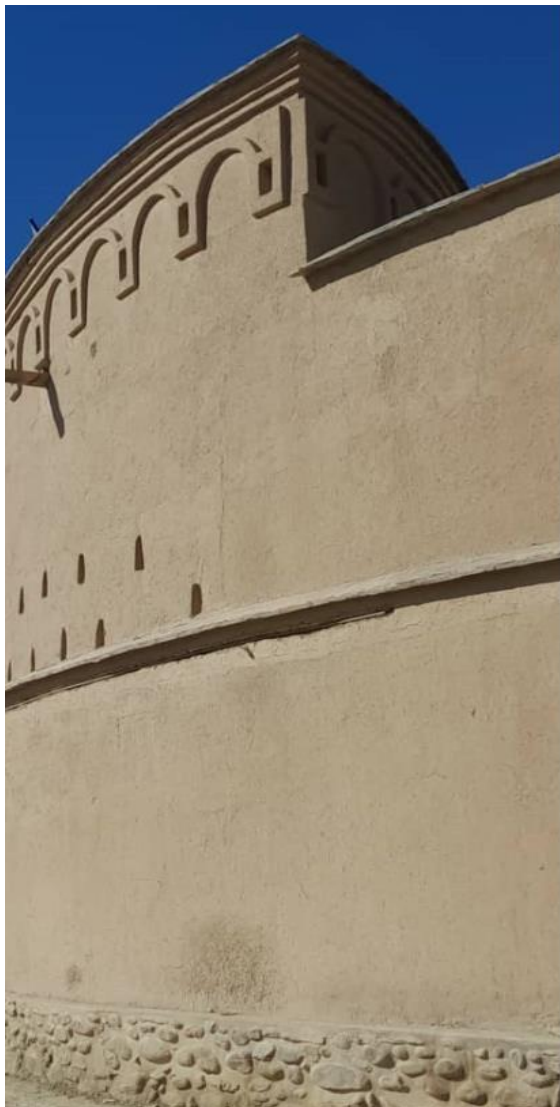
تصویری از قسمت بیرونی برج های داخلی قلعه
