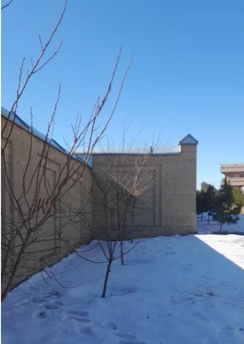
تصویری از دیوار احاطه قسمت سمت جنوب
