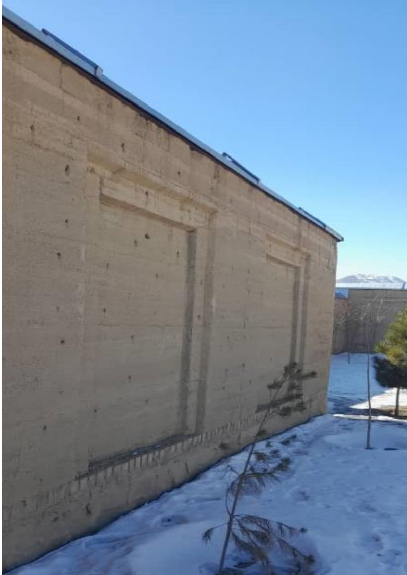
تصویری از دیوار احاطه قسمت سمت جنوب
