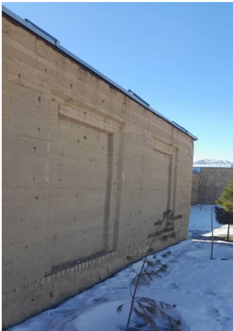
تصویری از دیوار احاطه قسمت سمت جنوب
