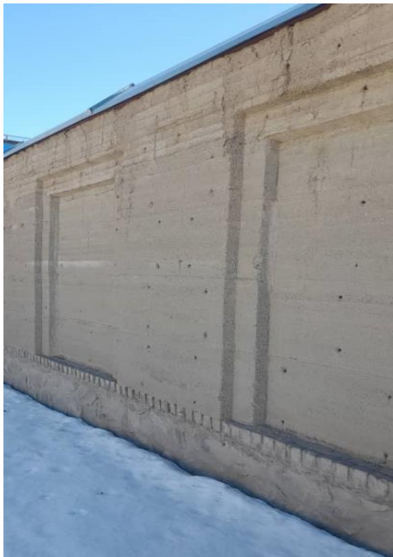
تصویری از دیوار احاطه قسمت سمت جنوب
