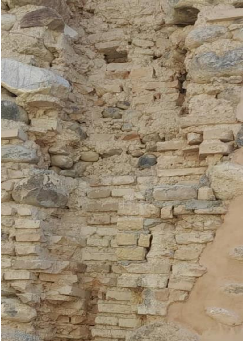
تصویر قسمت فوقانی ناوه خصی عمودی نیمه کاره تونل ها
