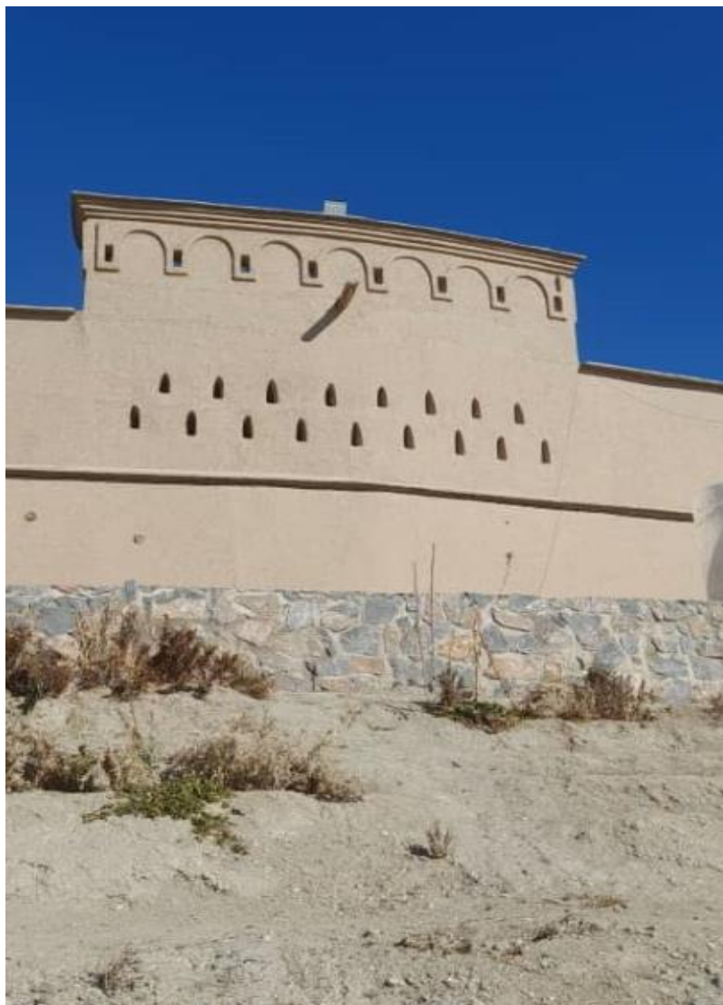
تصویری از قسمت بیرونی برج های داخلی قلعه
