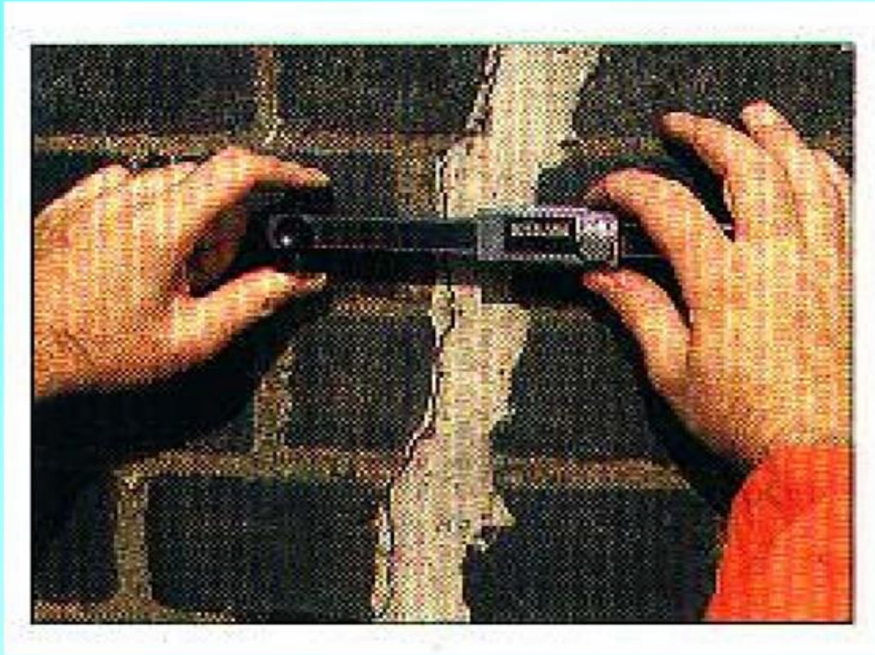
DIGITAL CRACK GAUGE - ELE
