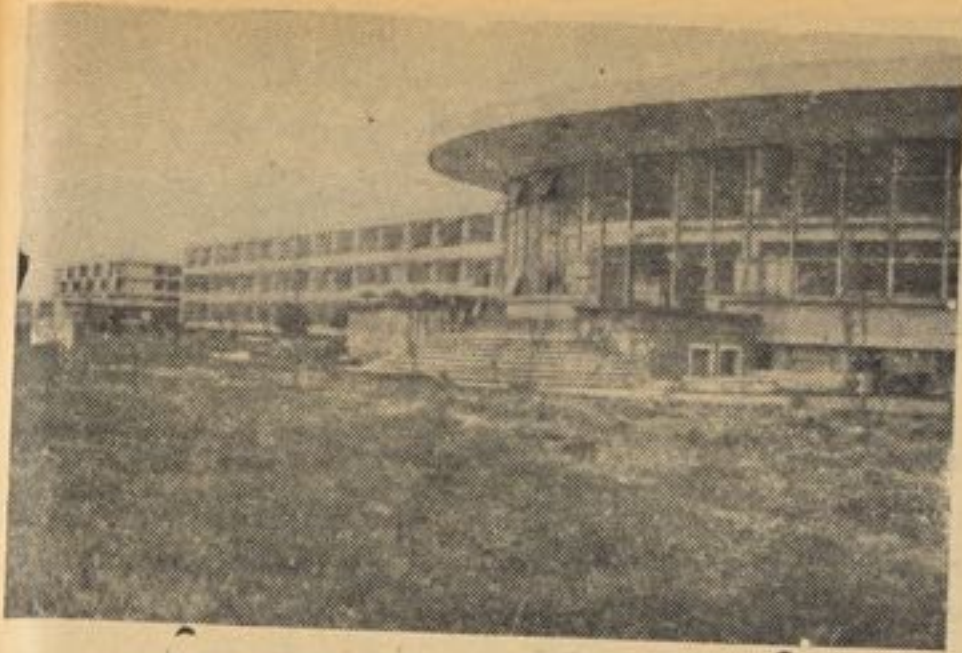
منظره از تعمیر تخنیک مزارشریف
