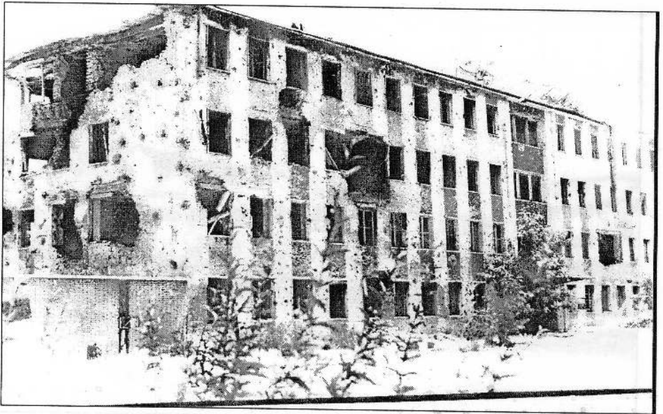
نمای تخریب شده فابریکه جنگلک دهه ۱۳۷۰
