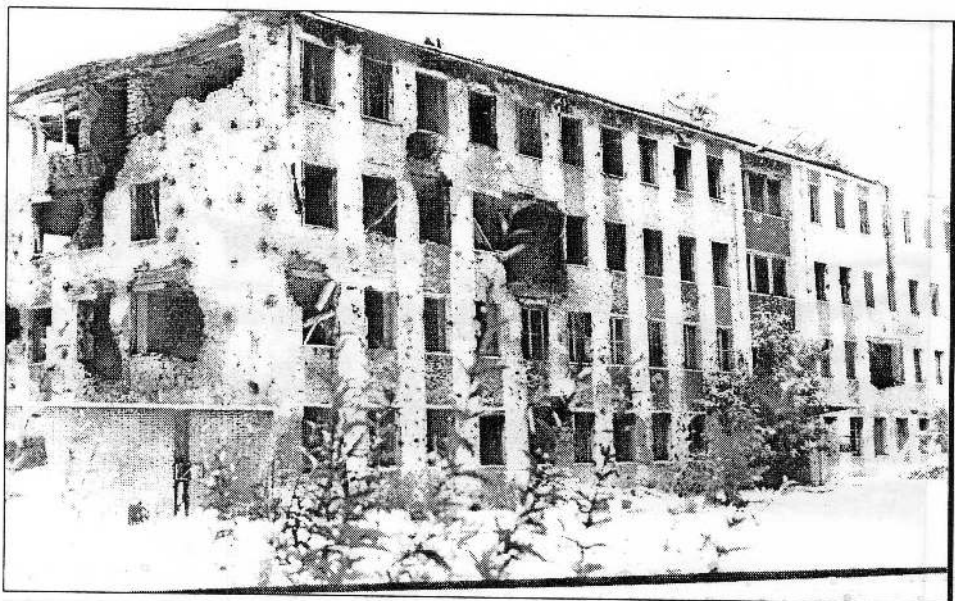
نمای تخریب شده فابریکه جنگلک دهه ۱۳۷۰
