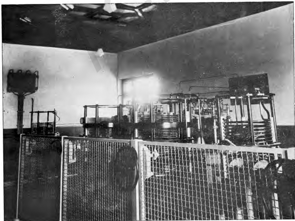
حصه ۴ و ۵ و مودتور دستگاه برود کاست ۲۰ کیلوواته در بکته توت
