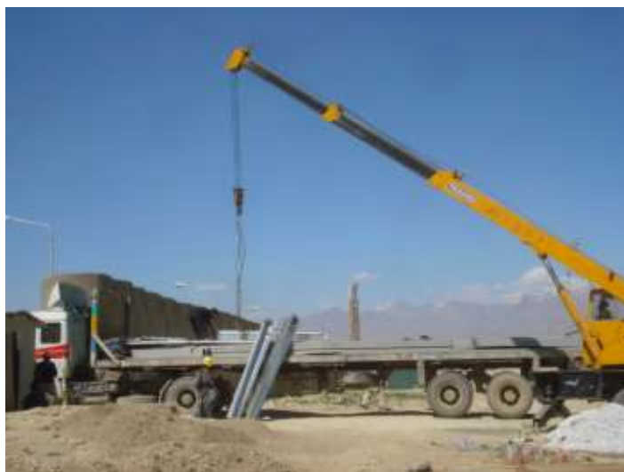
تصویری از پایین نمودن قطعات پیش ساخت در ساحه کاری
