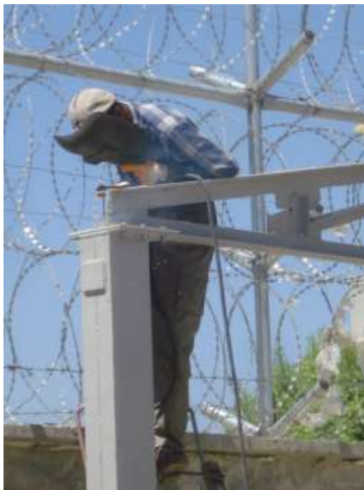
تصویری از محکم بندی ترس ها در سازه کاری
