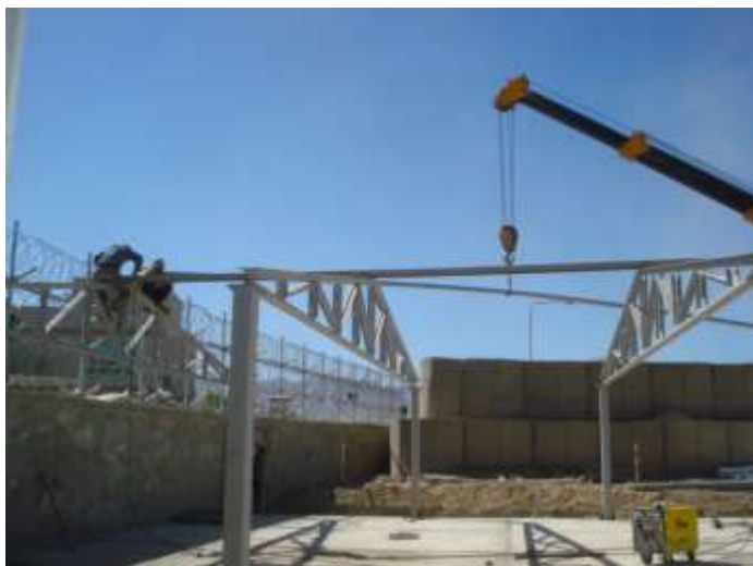
تصویری از نصب گادر های ارتباطی در سازه کاری
