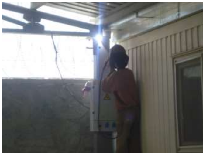
تصویری از نصب آهن چادر در سازه کاری
