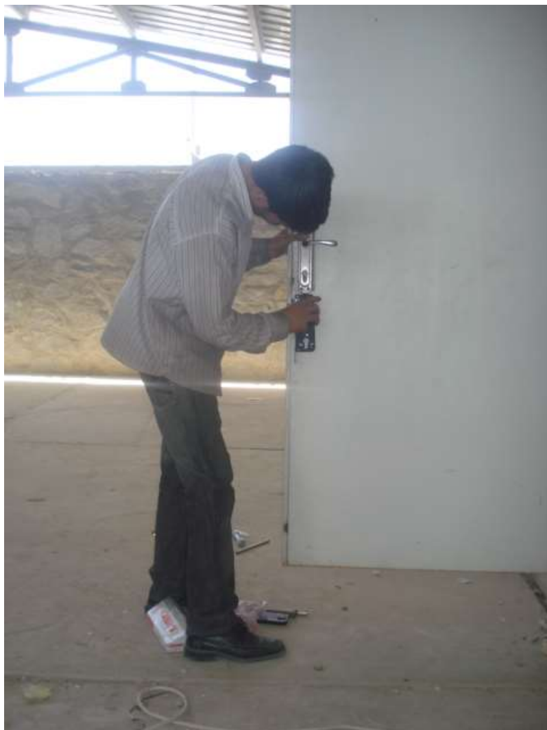
تصویری از نصب دروازه اتاق داخلی ورکشاپ
