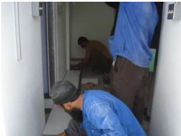
تصویری از نصب کاشی در فرش کانتینر
