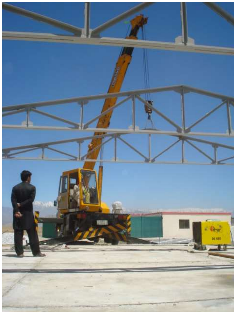
تصویری از نصب ترس ها در سازه کاری
