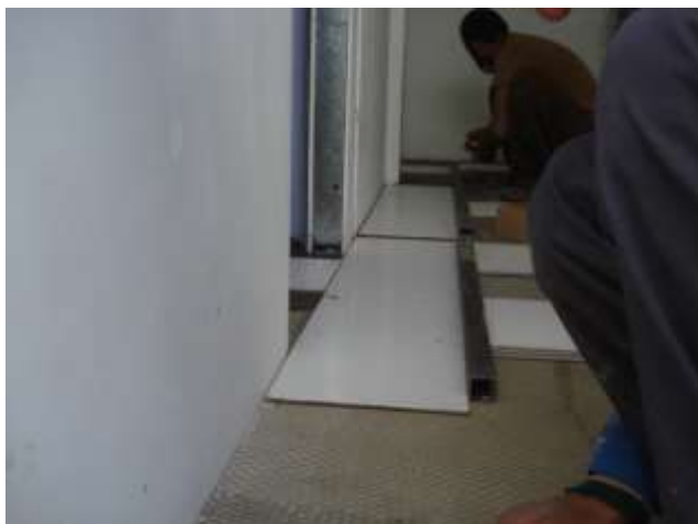
تصویری از نصب کاشی در فرش کانتینر
