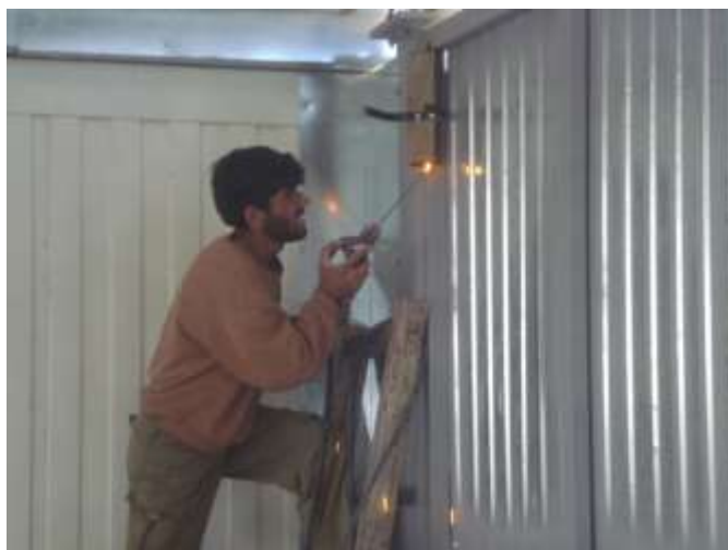
تصویری از نصب براکت برای چراغ ورکشاپ
