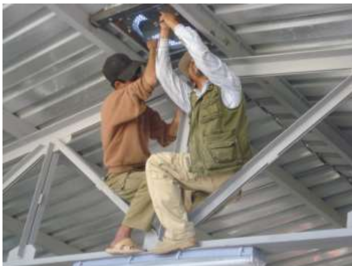
تصویری از نصب هواکش
