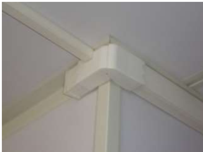
تصویری از نصب کاندویت برق کانتینر
