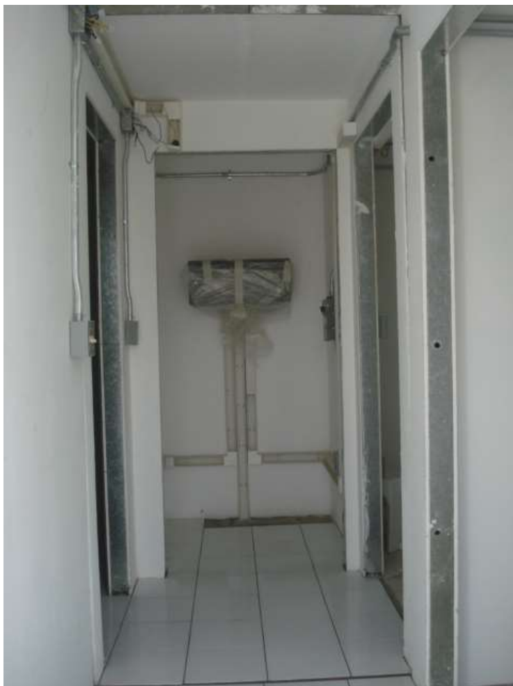
تصویری از نصب کاشی در فرش کانتینر
