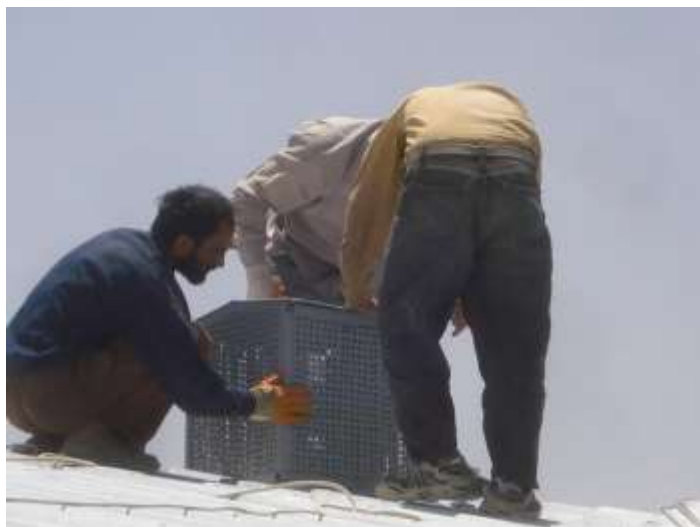
تصویری از نصب بکس هواکش
