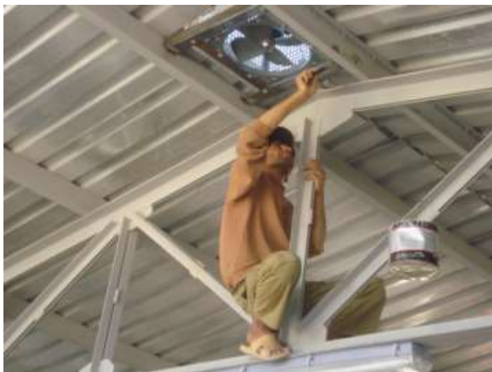
تصویری از نصب هواکش
