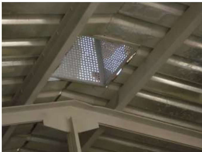
تصویری از نصب بکس هواکش
