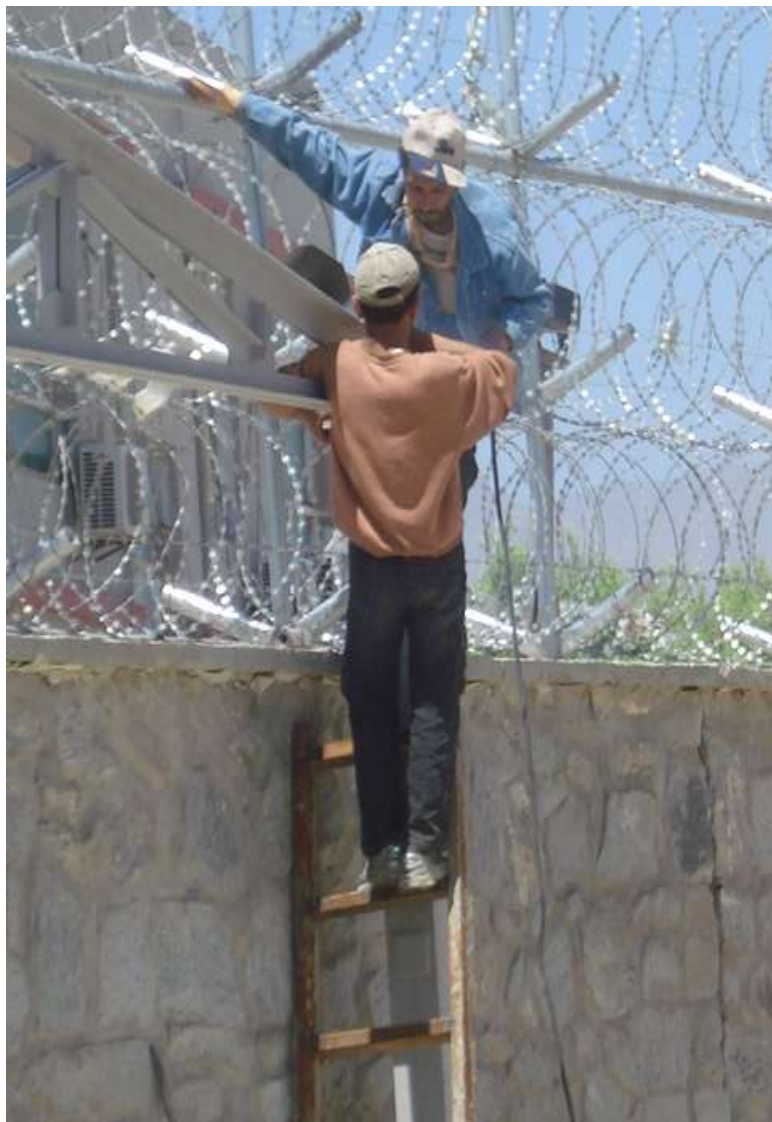
تصویری از پخته کاری ترس بالای پایه ها در ساحه کاری
