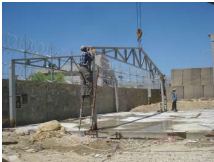
تصویری از نصب ترس ها در ساحه کاری
