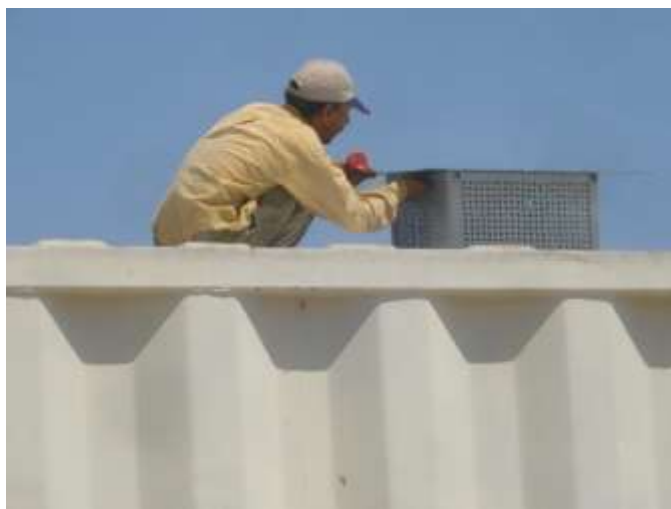
تصویری از کنترل بکس هواکش
