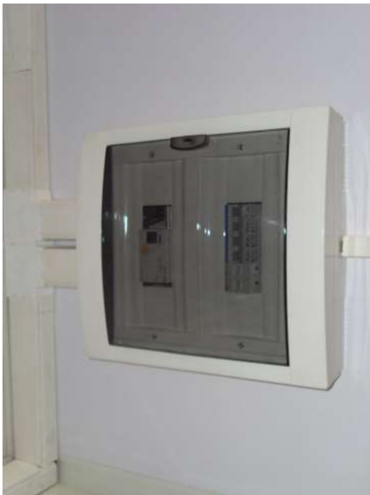
تصویری از نصب فیوز بکس داخلی کانتینر
