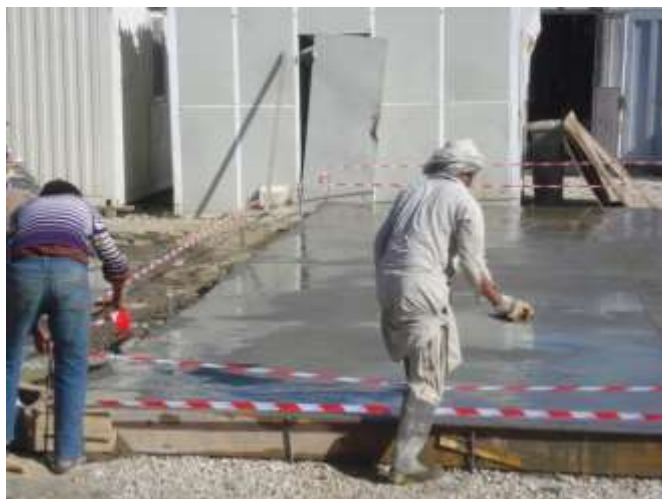
تصویری از صاف کاری کانکریت بعد از دوساعت کاری
