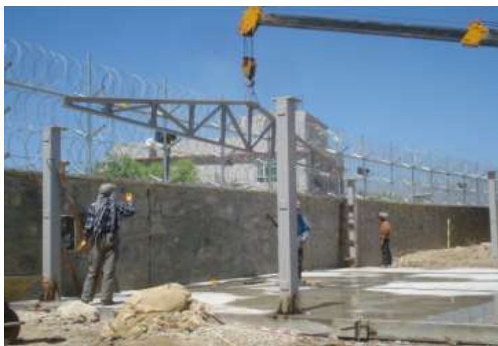
تصویری از نصب پایه ها در ساحه کاری
