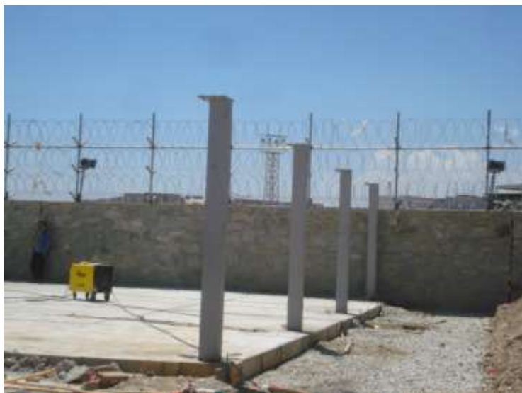
تصویری از نصب پایه ها در ساحه کاری
