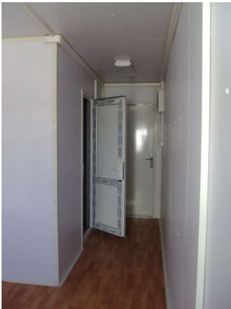
تصویری از نصب دروازه داخلی کانتینر
