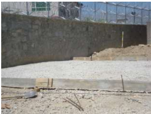
تصویری از قالب بندی اطراف ساحه برای ورکشاپ
