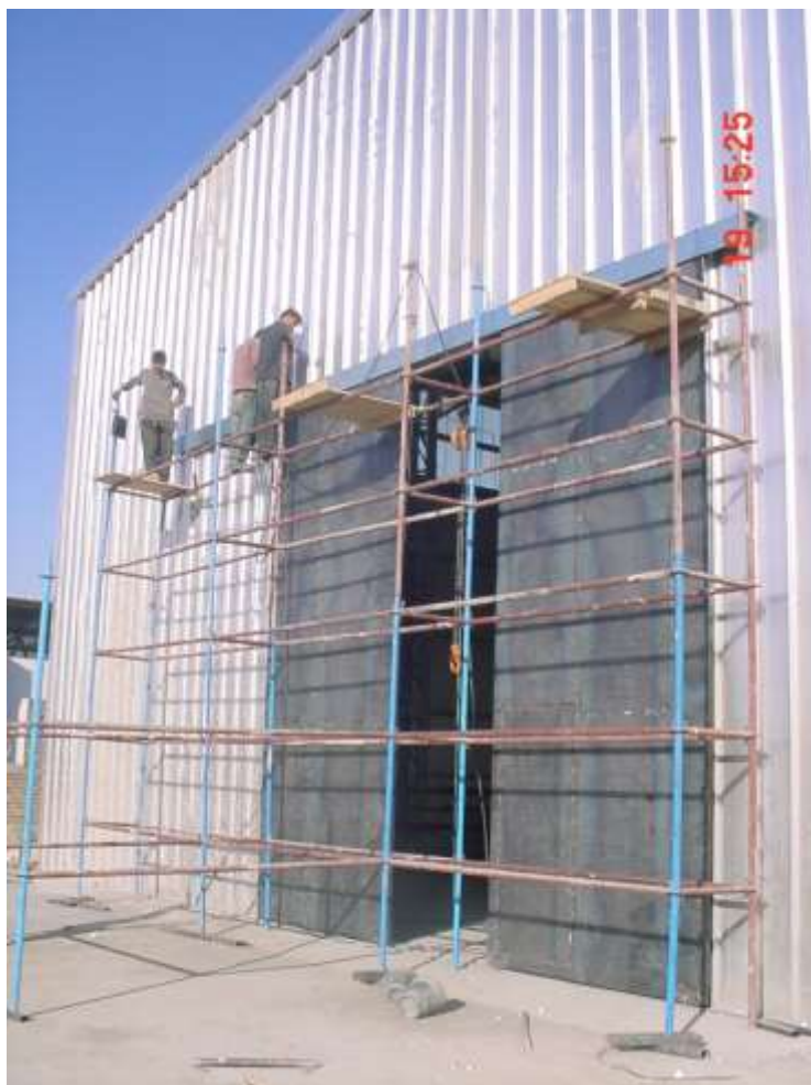
تصویری از ساختمان دروازه های فابریکه (سمت خارجی هنگر)
