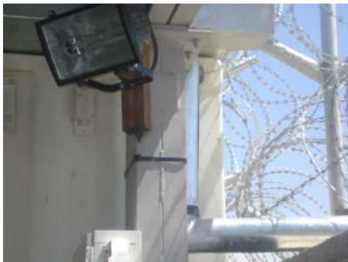
تصویری از نصب چراغ پروجکتور ورکشاپ
