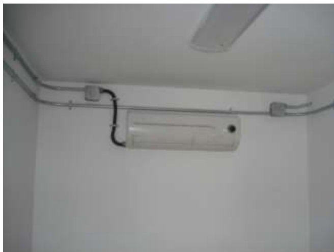
تصویری از نصب یونت داخلی آیر کندیشن معه سیستم (کانتینر)
