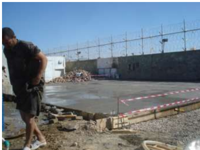
تصویری از ختم کانکریت ریزی
