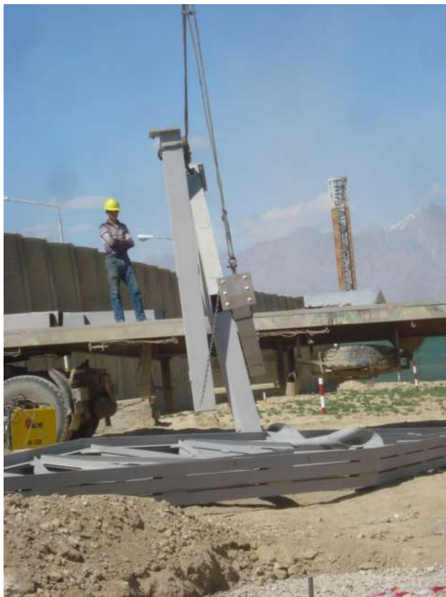
تصویری از پایین نمودن قطعات پیش ساخت در ساحه کاری
