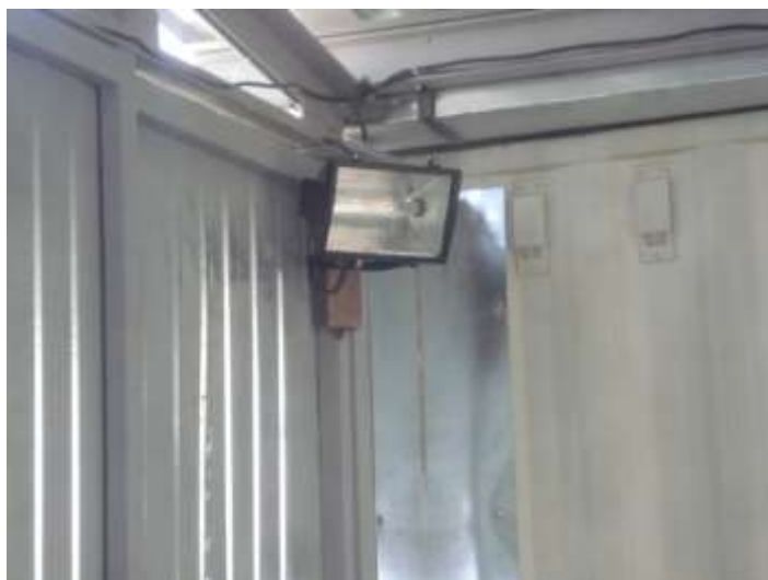
تصویری از نصب چراغ های پروجکتور در ساحه کاری
