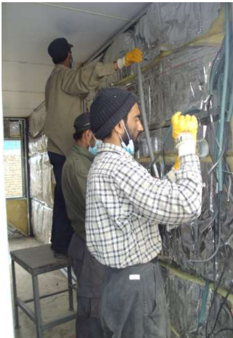
تصویری از عایق کاری حرارتی دیوار کانتینر
