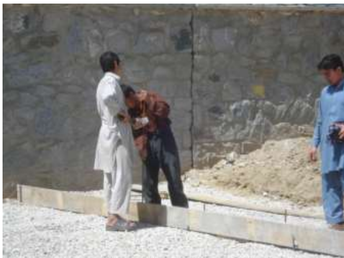
تصویری از قالب بندی ساحه برای ورکشاپ
