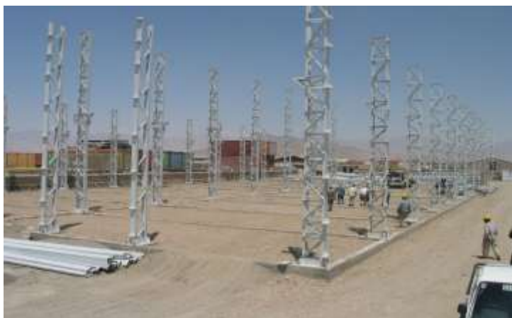
تصویری از نصب پایه های فلزی برای ساختمان فابریکه
