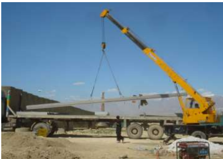
تصویری از پایین نمودن قطعات پیش ساخت در ساحه کاری
