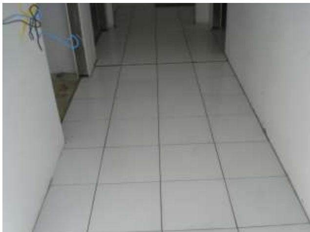
تصویری از نصب کاشی در فرش کانتینر
