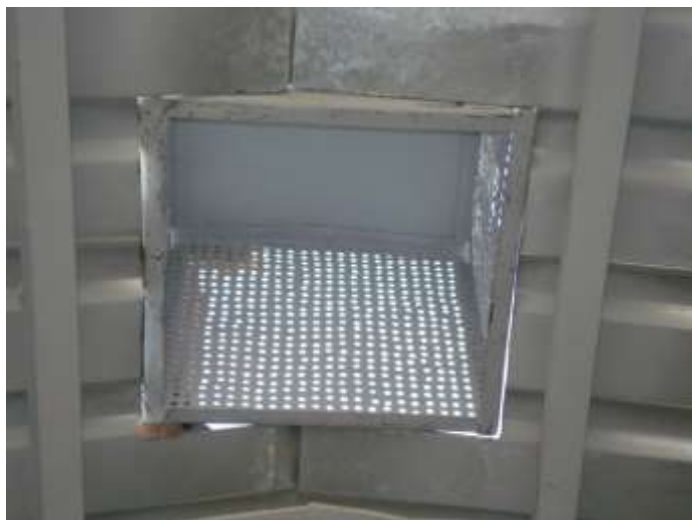
تصویری از نصب بکس هواکش
