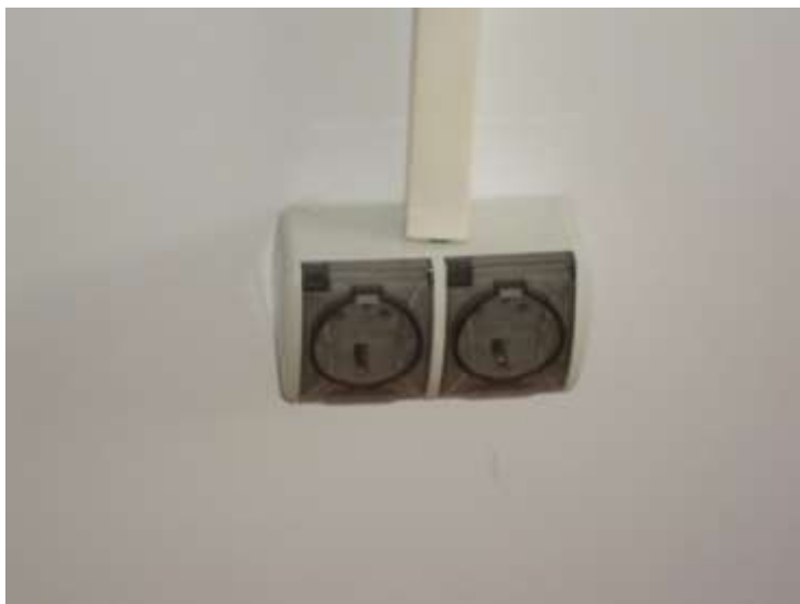
تصویری از نصب ساکت برق کانتینر
