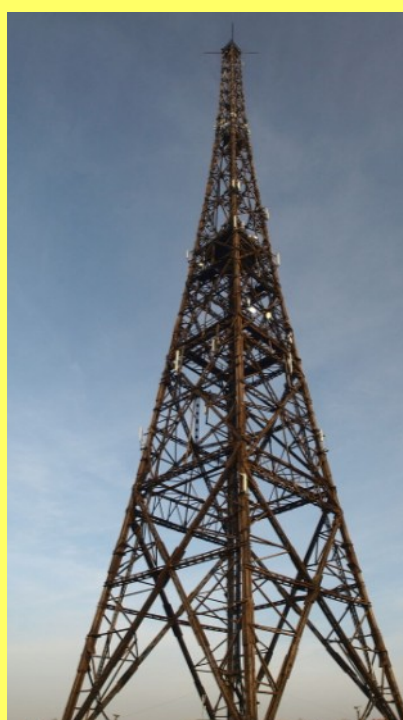
فرستنده ی ایستگاه گایویتس
